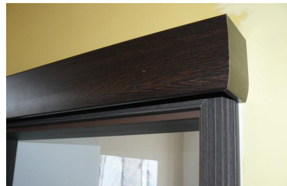
obr.4 Dokončená montáž garnýže
